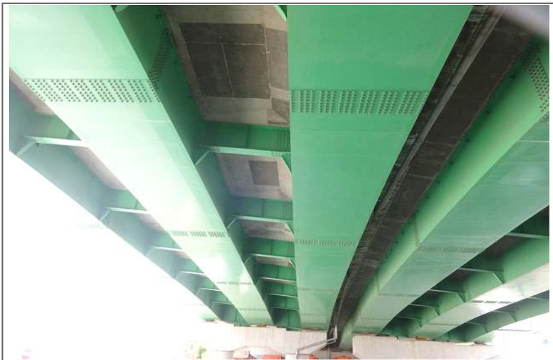
거더 및 바닥판하면 전경
